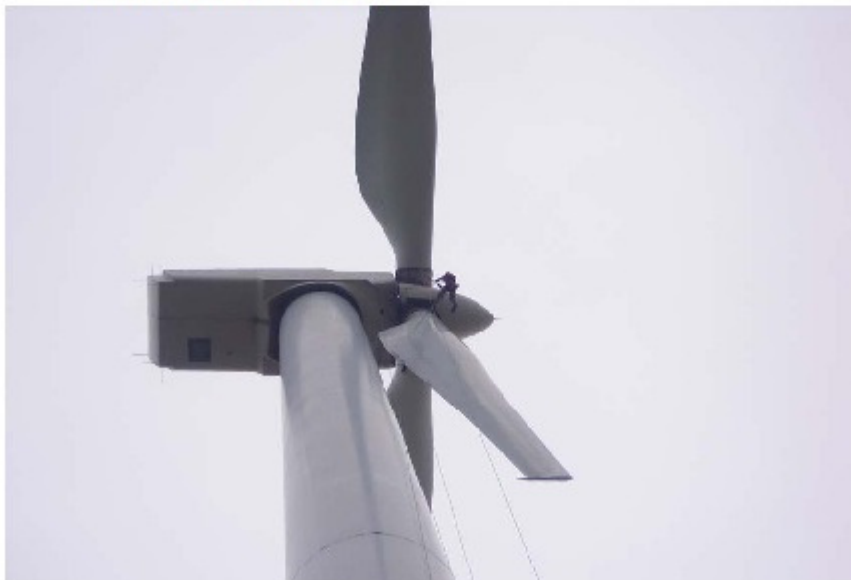
Rotorblatt-Inspektion (Windigo)
